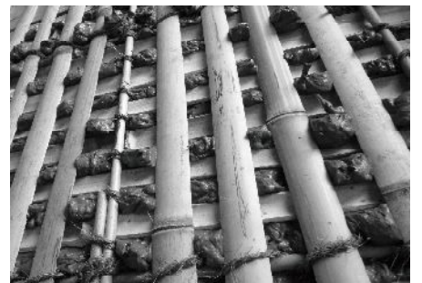
竹小舞下地荒壁土塗り
